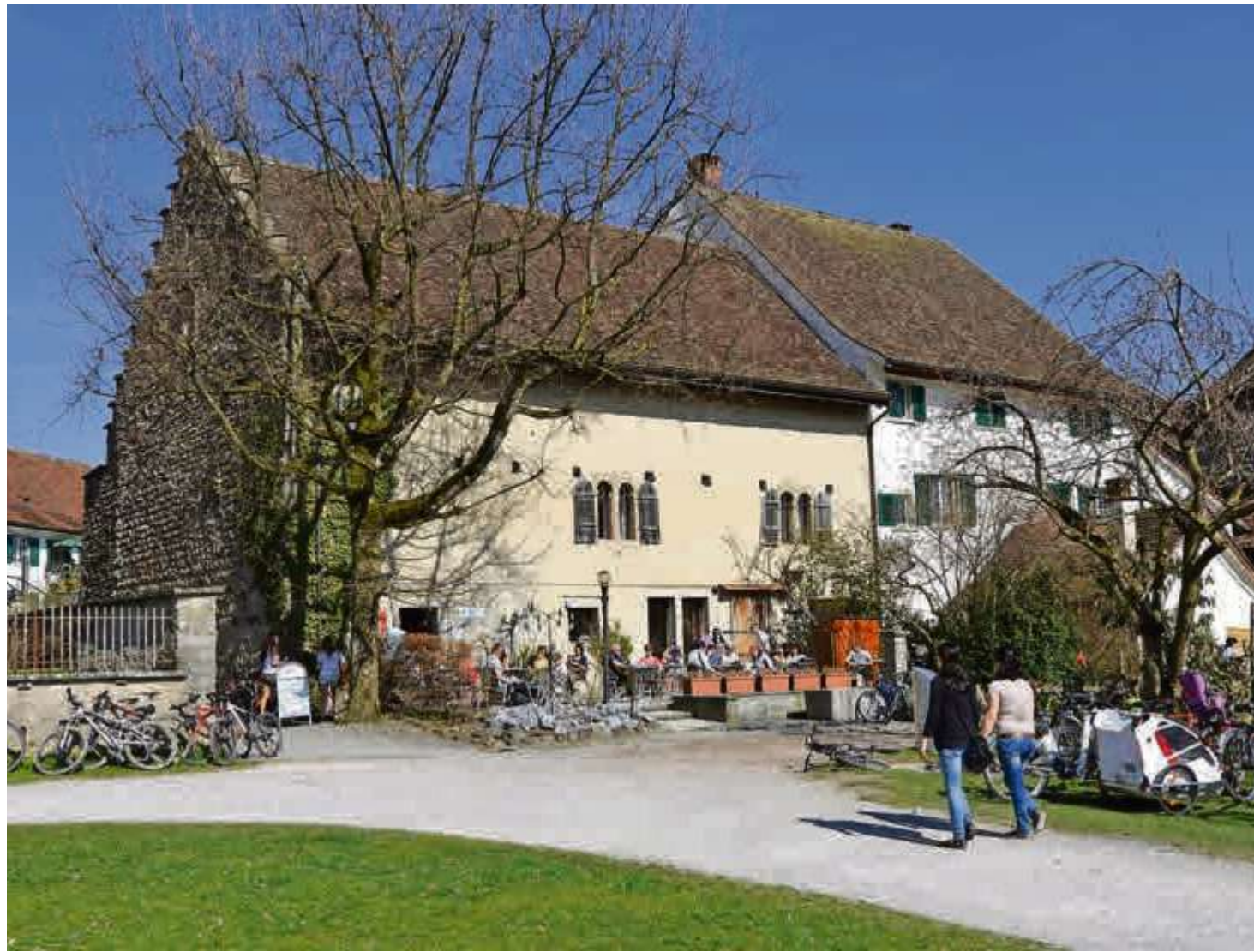
Darum geht es: die Seefassade des Landenberghauses mit dem angrenzenden Pfarrhaus (rechts). Der Gemeinderat möchte es mit 11,7 Millionen Franken vergrössern und modernisieren, der Kiosk soll zum Bistro aufgewertet werden. Doch das Projekt ist vielen zu ambitioniert – und zu teuer. zvg
