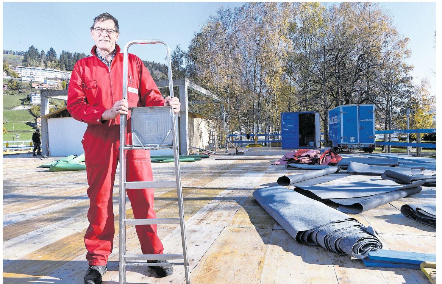
Unter Bauchef Hanspeter Kälin herrscht auf der Baustelle ein positives Arbeitsklima.
